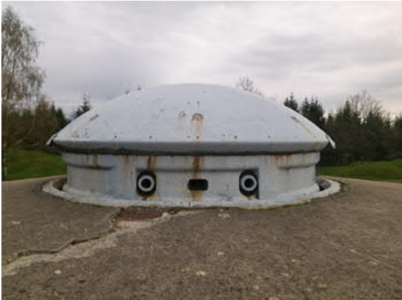
Der nächste Schauplatz: Ein Geschützturm des Werkes „Kalte Erde“. Hier scheiterte der dt. Hauptangriff vom 23. Juni 1916 © Rekonquista
